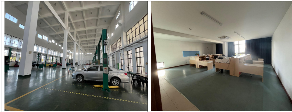
图 5-10 4# 实训楼内部现状
