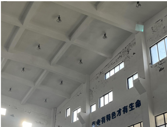
图 4-11 墙面脱落
